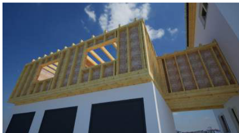
Prikaz okvirne konstrukcije tijekom gradnje.
